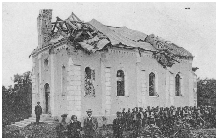
Bojmi poškodený kostol v Chotči
