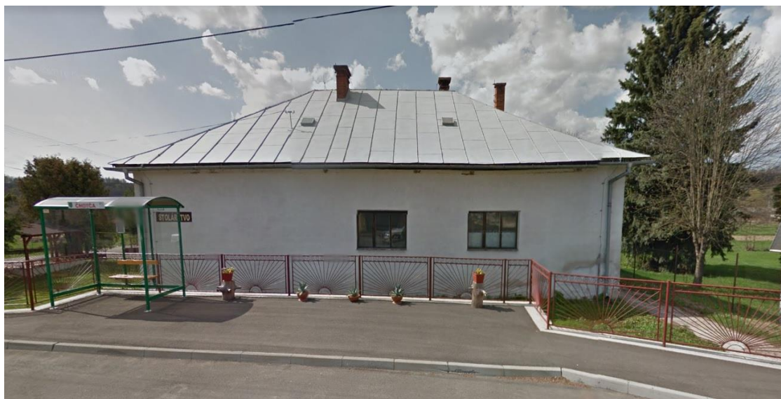
Dnešná budova starej školy z roku 1901
